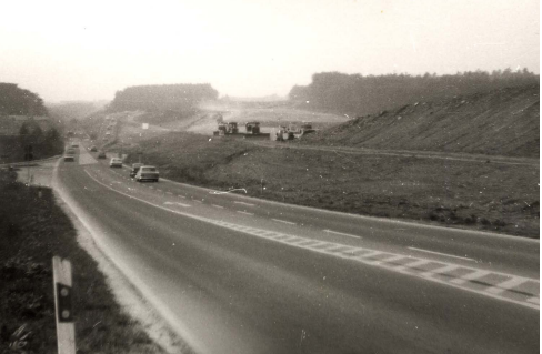
1972 - Bau der A 61
